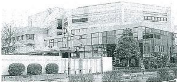
耐震補強工事のため1月から休館している島根県民会館。松江市殿町
